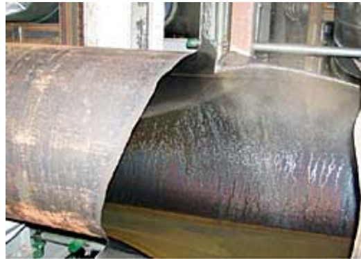
復水配管の破損部分。配管の厚さは基準に満たない1.4ミリ-3.4ミリしかなかった(関西電力提供)
